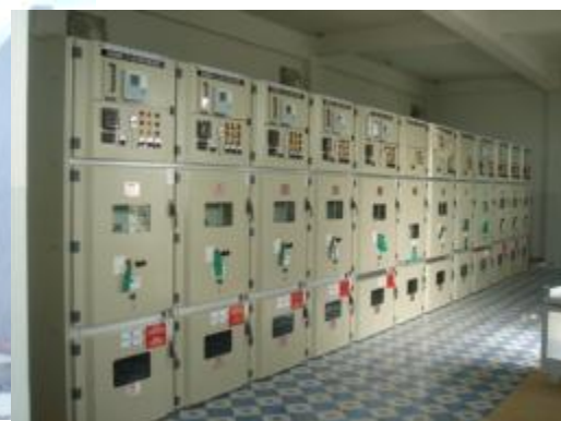
22kV Switchgear
