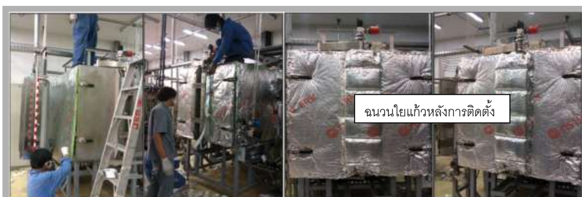
รูปที่ 5 การติดตั้งฉนวนกันความร้อนให้กับเครื่องฉาบกระจก CVD
