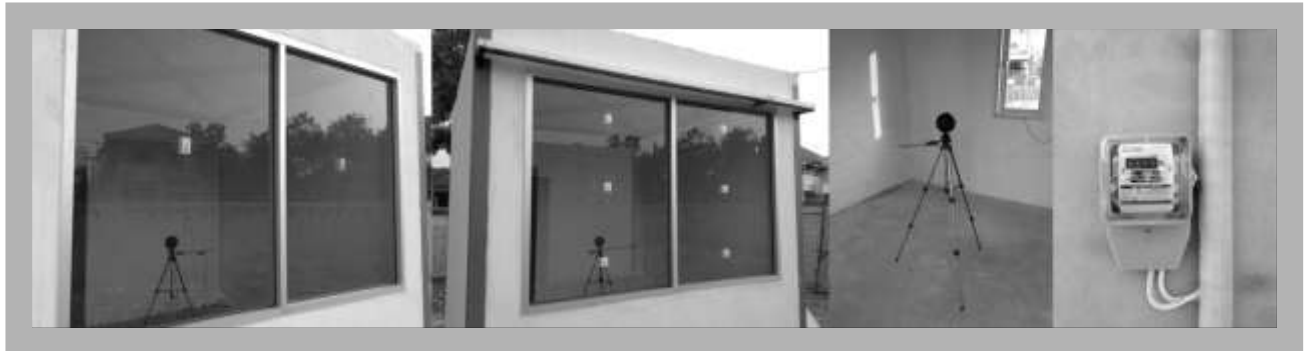
ภาพที่ 6 แสดงการติดตั้งเครื่องมือเก็บข้อมูลอุณหภูมิผิวกระจกภายใน globe temperature และมิเตอร์วัดพลังงานไฟฟ้า
