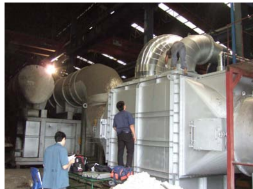
รูปที่ 9 recuperator ใหม่ที่ได้ติดตั้งแล้ว
