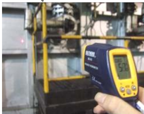
รูปที่ 4 การวัดอุณหภูมิผนังเตา reheating furnace
