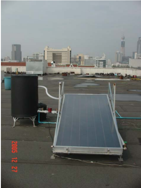
รูปที่ 3 ระบบทำน้ำร้อนแบบแผ่นเรียบ
