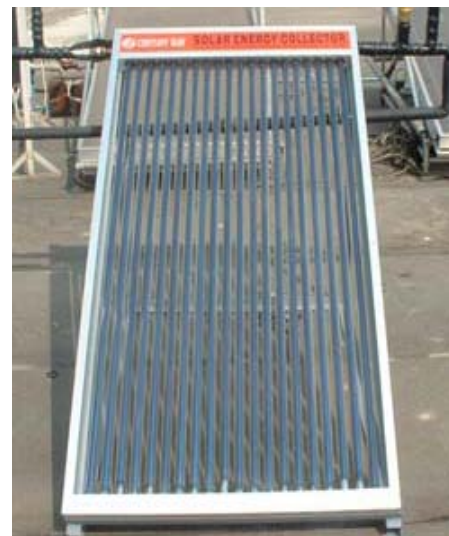
รูปที่ 2 แผงรับแสงอาทิตย์แบบท่อฮีทไปป์
