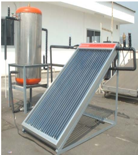
รูปที่ 4 ระบบทำน้ำร้อนแบบท่อฮีทไปป์
