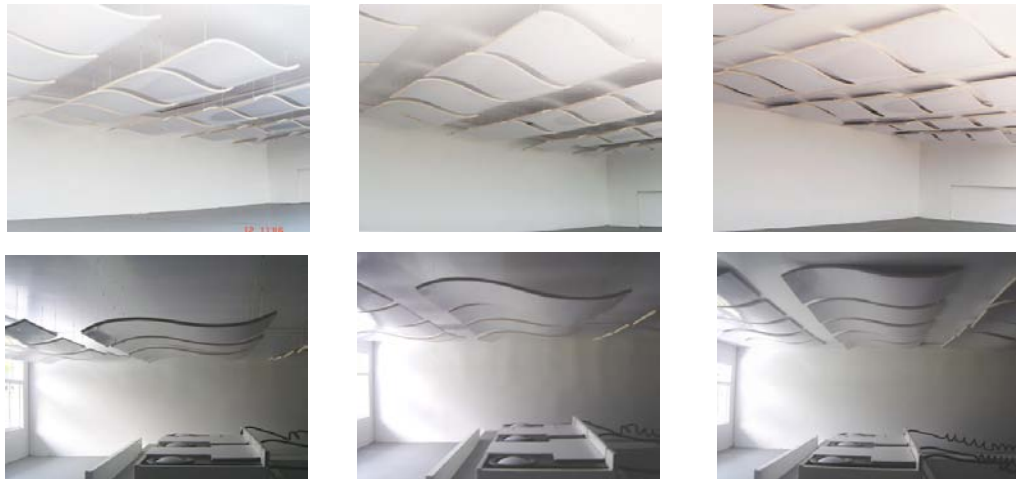
ภาพที่ 7 เปรียบเทียบระดับติดตั้งของแผงสะท้อนแสงเหนือระนาบทำงาน
